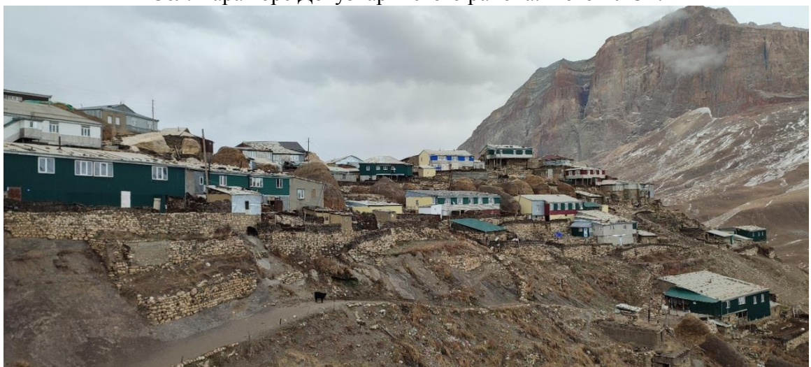
17. Вид на один из кварталов с. Куруш Докузпаринского района с сооруженными над дорогой подпорными стенами. Фото 2023 г.
