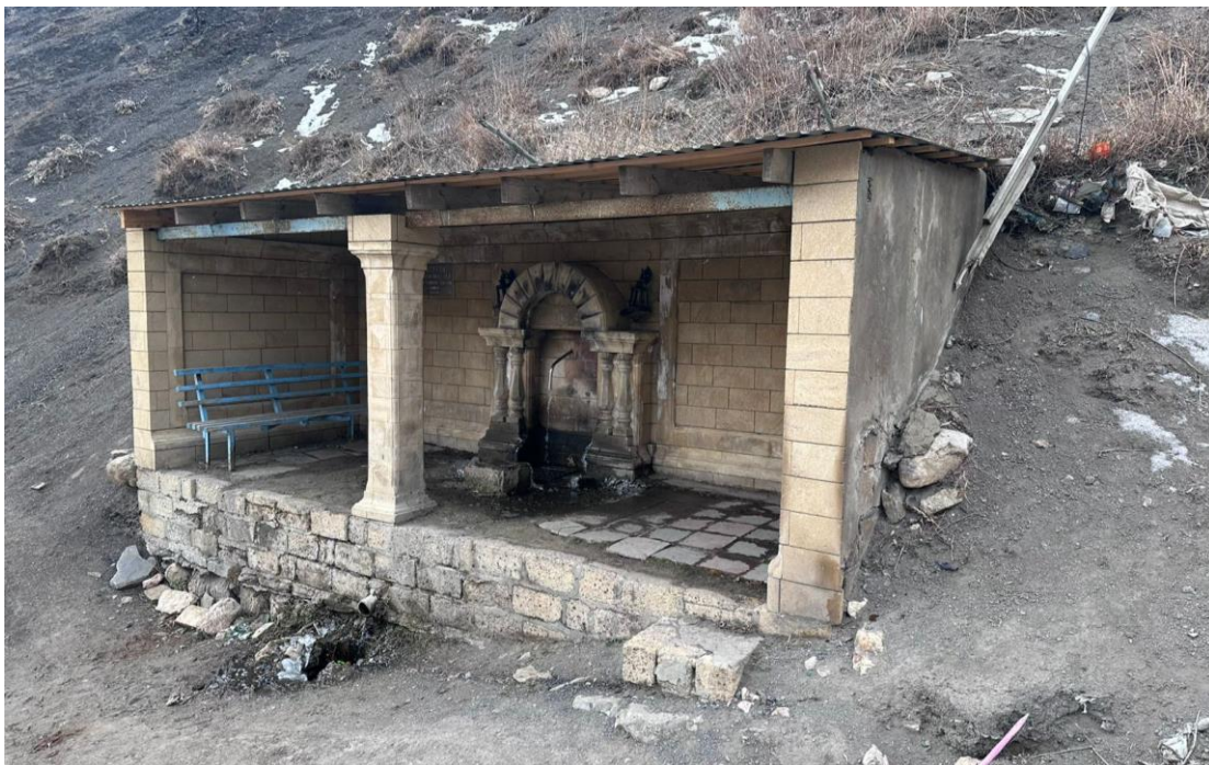
21. Построенное в 2004 г. природническое сооружение в с. Куруш Докузпаринского района. Фото 2023 г.
