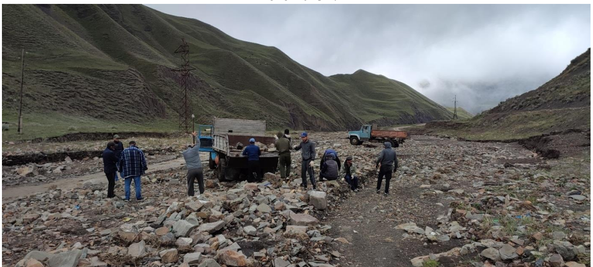
46. Общественная взаимопомощь («мел») в с. Хпедж Курахского района. Сбор речного камня, используемого при закладке фундамента жилища. Фото 2023 г.
