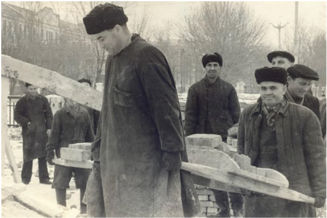
Фото 38. Х.М. Бербеков на строительстве дома научных работников КБГУ, 1959 год. (Фототека УЦГА АС КБР. № 2388)
